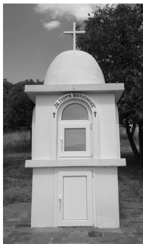
Параklисът в Ефрем е подобен на този в Сачанли, за да се подчертае приемствеността между двете исторически селища, населявани от тракийски българи
