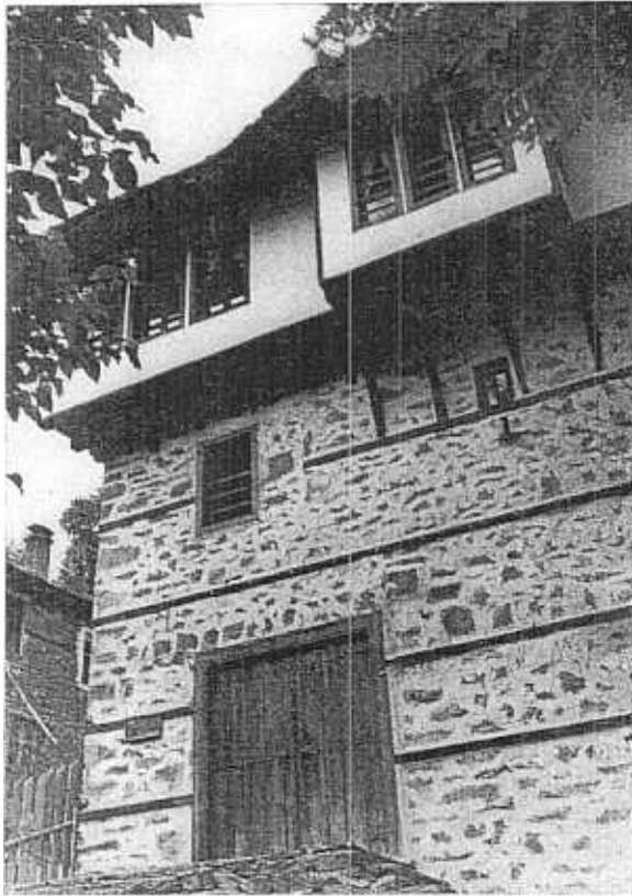
2. Chiroka Laka. Maison de repos de l'Union des architectes bulgares.
